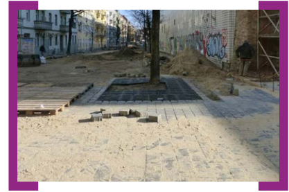
Umbau der Neckarstraße © BSG
