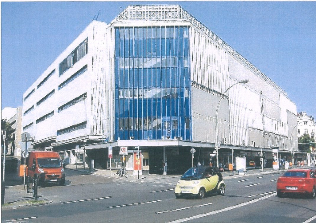
Das frühere Hertie-Kaufhaus an der Karl-Marx-Straße wird komplett umgebaut.
