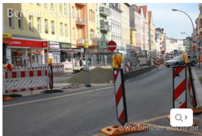
Baustellen mit mehreren Bauherren - wie aktuell die Karl-Marx-Straße - brauchen Koordination. (Foto: Josephine Macfoy)
