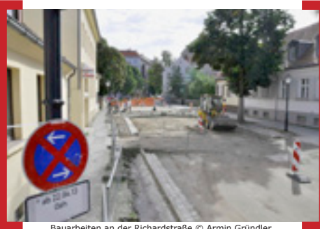
Bauarbeiten an der Richardstraße © Armin Gründler
