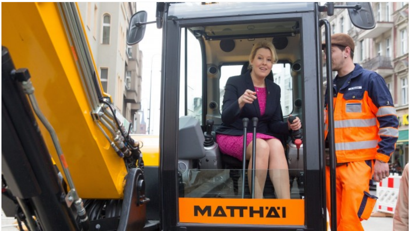
Bezirksbürgermeisterin Franziska Giffey (37, SPD) stemmt die Straße auf Bauarbeiten Baustelle (Foto: Ralf Guenther)
